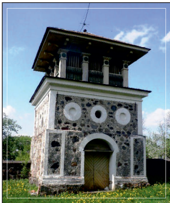
Pabaisko Šv. Trejybės bažnyčios varpinė
